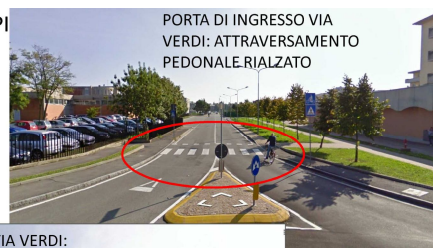
FIGURA 6.3.7 – ESEMPIO DI INTERVENTI DI MODERAZIONE DEL TRAFFICO SU ATTRAVERSAMENTI PEDONALI
